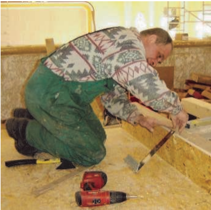
Уже видна красота зала. Сейчас здесь укладывают паркет.
